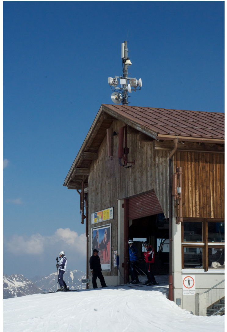
Die Access Points von Meraki an exponierter Stelle im Außenbereich...
